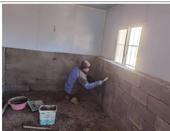
危废暂存间防渗
